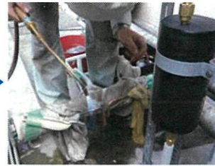
液管側に「α-HT」接続
